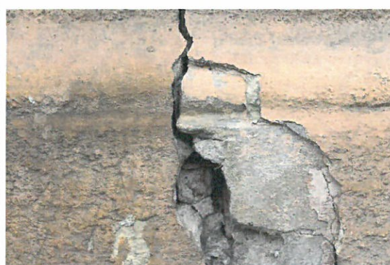
Cornișă superioară – desprindere elemente de consolă cu pierdere și risc de cădere, foto în continuare.
