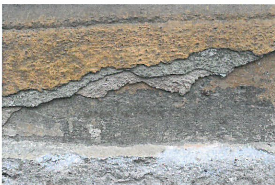
Cornișă superioară – desprindere elemente de consolă cu pierdere și risc de cădere, foto în continuare.
